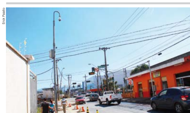
Câmera foi danificada por um caminhão, que arrebentou os fios do equipamento
